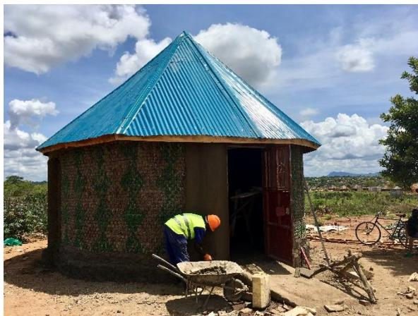
Schon die Unterrichträume sind sehr neuartig. So entstehen zum Beispiel ganze Häuser aus Plastikflaschen, die mit Lehm gefüllt werden. Die Bodenbeläge sind zum Teil aus Eierschalen. Auch eine sinnvolle Wiederverwendung von Glas, die Herstellung von Briketts aus Biomasse oder der Bau eines Biogas-Systems, sind Teil des Projekts.
